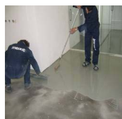
Figuras 11 a 13 - Aplicação de revestimentos epóxicos: da esquerda para a direita, pintura, sistema multicamada e revestimento autonivelante
