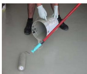
Figuras 11 a 13 - Aplicação de revestimentos epóxicos: da esquerda para a direita, pintura, sistema multicamada e revestimento autonivelante
