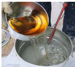
Figuras 9 e 10 - Mistura dos componentes reactivos (à esquerda) e adição de cargas ao argamassado (a direita)
