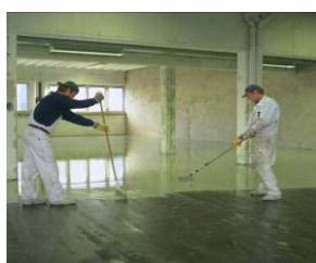
Figuras 11 a 13 - Aplicação de revestimentos epóxicos: da esquerda para a direita, pintura, sistema multicamada e revestimento autonivelante
