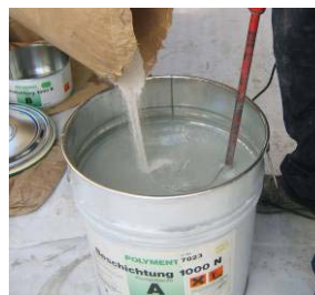
Figuras 9 e 10 - Mistura dos componentes reactivos (à esquerda) e adição de cargas ao argamassado (a direita)
