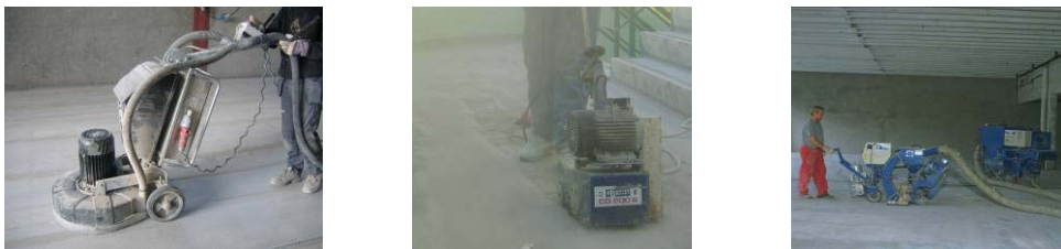
Figuras 6 a 8 - Tratamento mecânico ao suporte: da esquerda para a direita, polimento, fresagem e granalhagem
