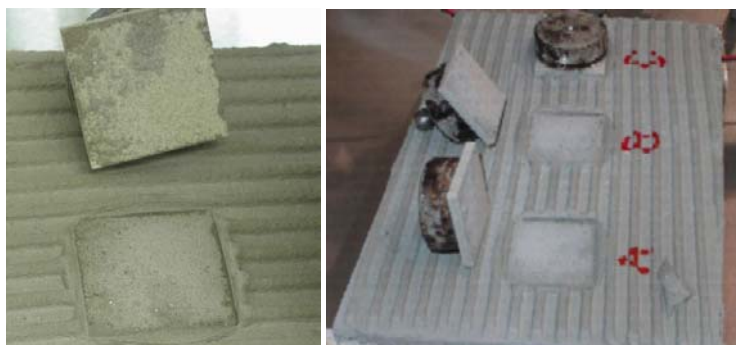
Figura 8 – Rotura adesiva na interface entre o ladrilho cerâmico e o cimento-cola – Provete PE0.2.
