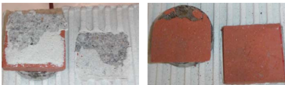
Rotura coesiva no seio do suporte.
