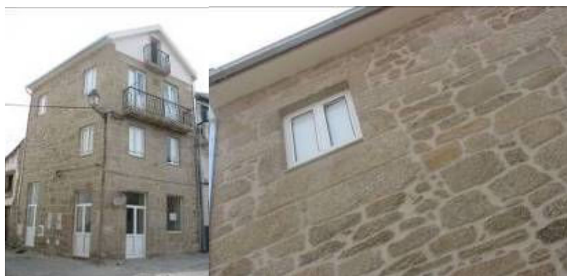
Figura 23 – Aspecto da argamassa aplicada
