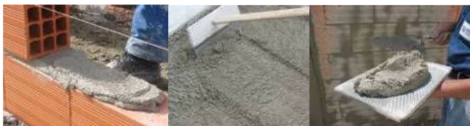
Figura 13 – Alvenaria, betonilha e reboco
