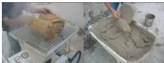
Figura 22 – Preparação da argamassa
