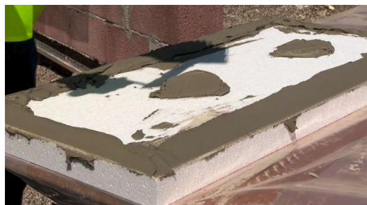
Colagem perimetral com pontos (área > 60% da placa)
