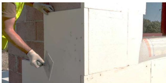
Travamento das esquinas
