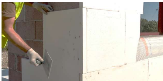
Travamento das esquinas
