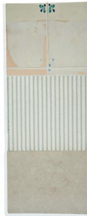
**Fig. 6** - Exemplo de renovação de revestimento sobre cerâmica preexistente.
