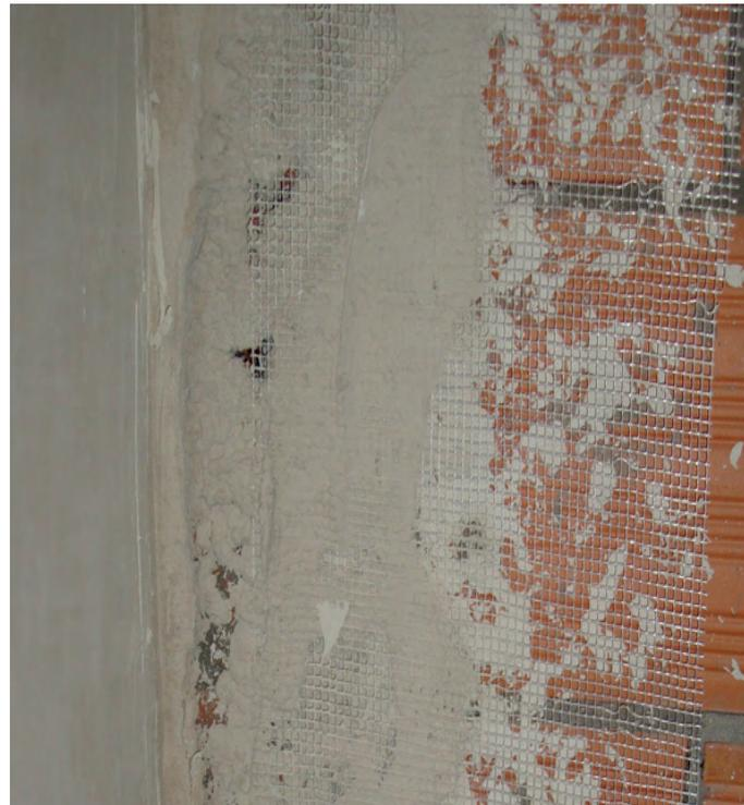
**Fig. 2** - Exemplos de rebocos de Gesso
