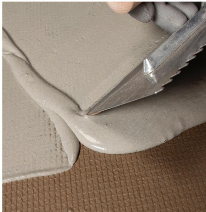
**Fig. 5** - Exemplo de membrana de impermeabilização cimentícia.
