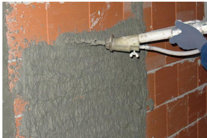
**Fig. 1** - Exemplos de rebocos de Cal e/ou Cimento
