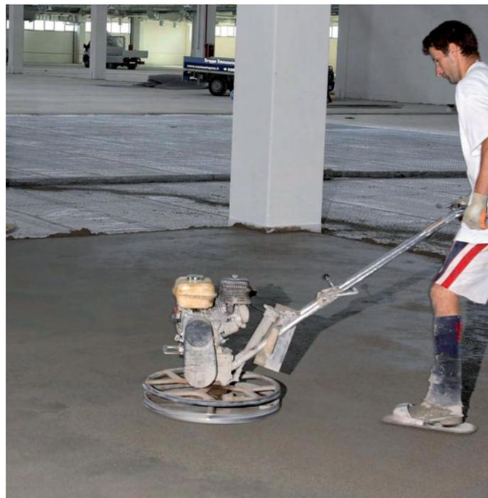
**Fig. 9** - Exemplos de betonilhas.
