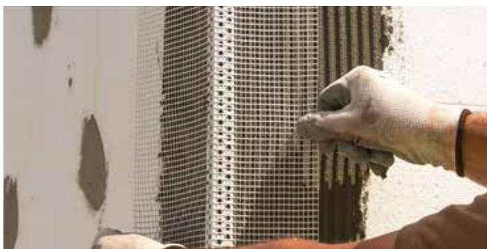
Se for necessária uma segunda rede de reforço (p.ex. na zona do lambriel), deve assegurar-se que é aplicada sem sobreposição e somente após endurecimento suficiente da camada de base com rede (consultar instruções do fabricante).
