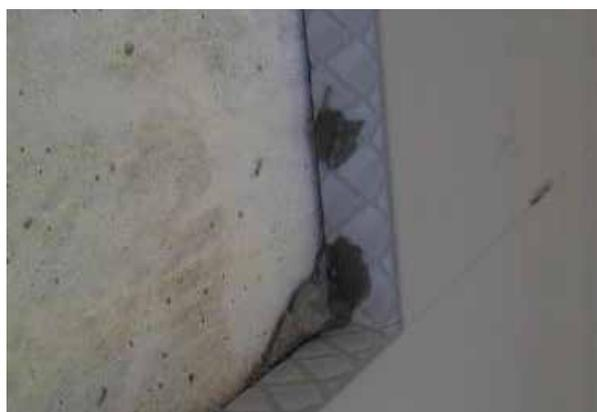
Após o assentamento, exercer uma ligeira pressão com uma talocha, para aumentar a aderência ao suporte, ajustando o alinhamento com os painéis adjacentes. É importante controlar frequentemente a planeza de toda a superfície com uma régua de nível.
