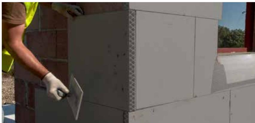
Na colagem da última fiada de placas isolantes que confina com o beirado ou rufo, pode prever-se o método de dupla colagem (painel e suporte) entrecruzado: aplicação dentada com dentes dispostos verticalmente no painel e horizontalmente no suporte, de forma a eliminar a penetração e escorrimento de água no seio do paramento no caso duma eventual infiltração. No entanto, o sistema no topo deve ser sempre protegido pelo beirado ou rufo.
