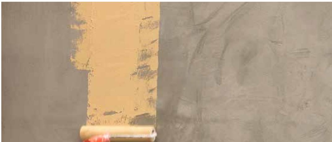
Após o período de secagem do primário, indicado pelo fabricante, pode ser executado o acabamento utilizando um revestimento espesso colorido, em pasta, aplicado segundo as instruções do fabricante.
