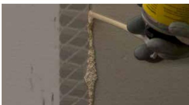
Nos vãos de portas e janelas ou na presença de materiais distintos (p. ex. tijolo e betão) as juntas entre placas não devem coincidir com as esquinas dos vãos ou do perímetro dos materiais distintos.
