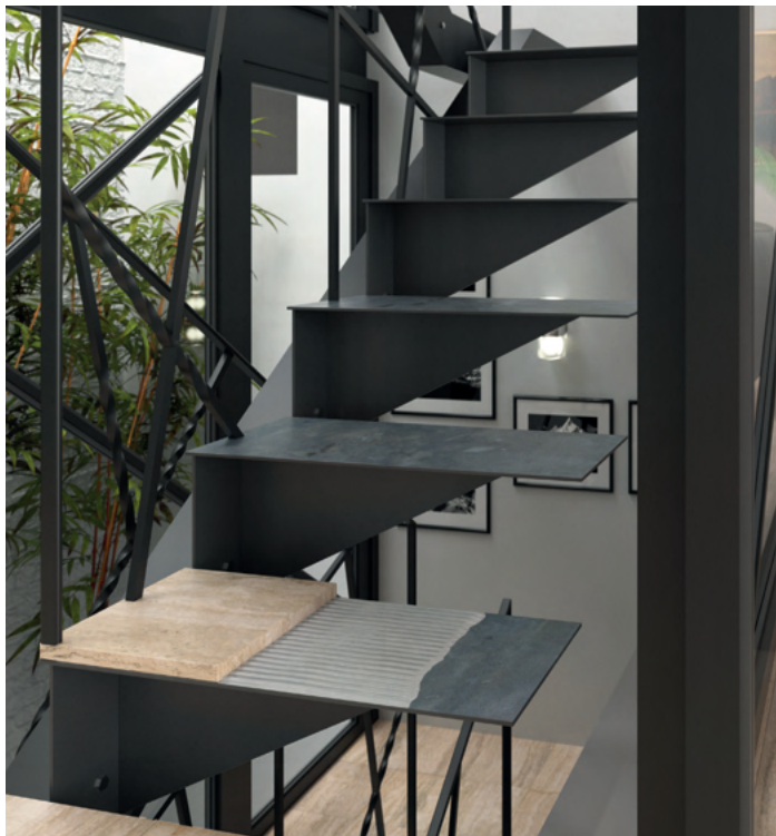
Fig. 7 - Exemplo de renovação de revestimento sobre suportes metálicos.
