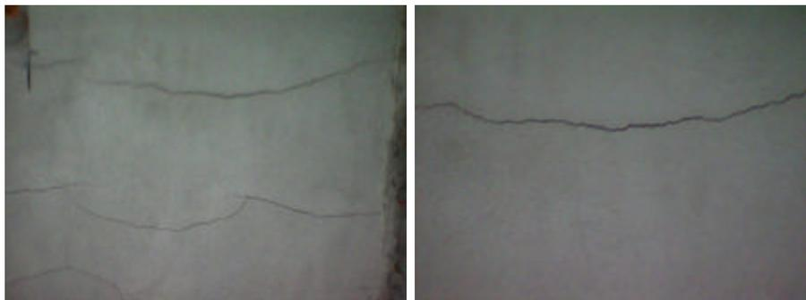
**Figura 32: Aspectos da patologia na argamassa com adição de 10% de cimento.**
