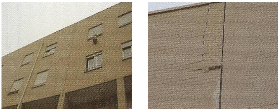
**Figura 30: Junta de dilatação estrutural não eficaz para o revestimento**
